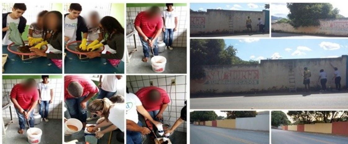
Figura 3- Limpeza do muro, preparação e aplicação da tinta.
