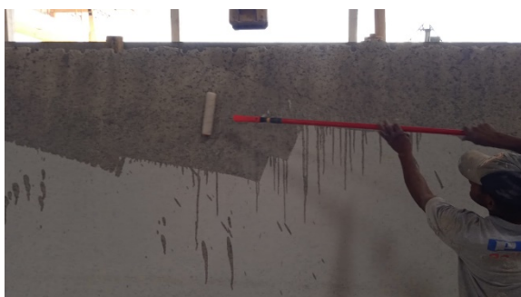
Figura 2 – Aplicação do ácido em chapas de rocha ornamental com rolo de pintura.
